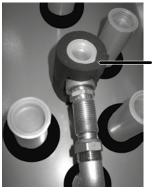
Restliche Verrohrung des Zirkulationsanschlusses mit 220 mm langen Isolationsschlauch (1) isolieren.
