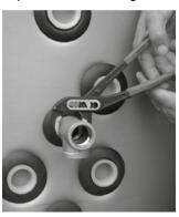
3. Das Gewinde des flexiblen Wellrohres aufdichten und in das T-Stückes einschrauben.
