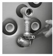
5. Das flexible Wellrohr strecken und zwischen Bogen und flexiblen Wellrohr die Dichtung einlegen.
