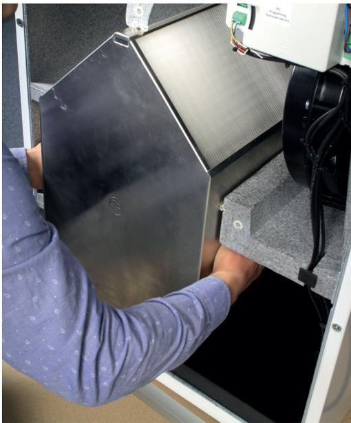
Achten Sie beim Herausnehmen des Wärmetauschers darauf, dass die überaus empfindlichen Lamellen nicht berührt werden. Defekte Lamellen beeinträchtigen die Fähigkeit zur Wärmerückgewinnung und erhöhen den Druckabfall im Wärmetauscher.
