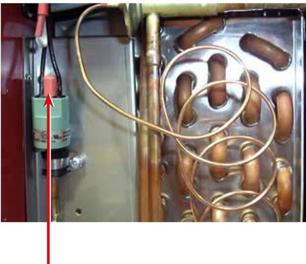
Beim Zurücksetzen (Reset) wird die rote Taste gedrückt.
